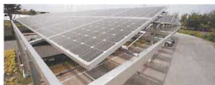
En ombrière de parking
