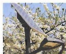
Sur l'éclairage public
